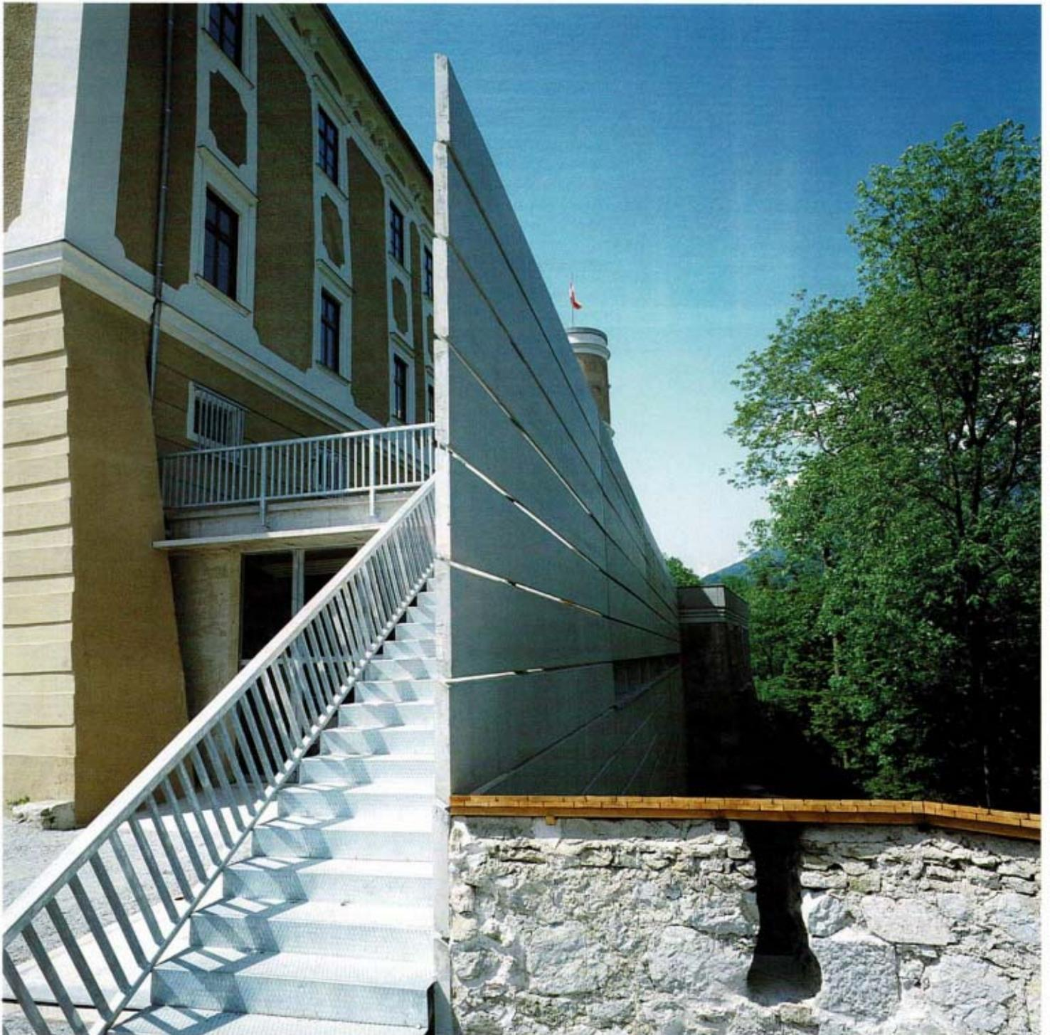
Die neue Bastion aus Stahlbetonfertigteilen
